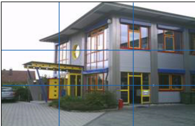
Siège de l'entreprise : Sachsenheim, près de Stuttgart / Allemagne
